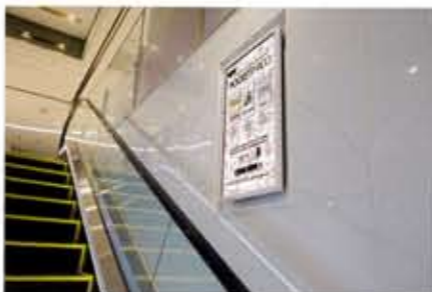
▲ エスカレーター横のデジタルサイネージ。32インチの液晶ディスプレイ(解像度FHD、輝度450cd/m 2 )1面。
